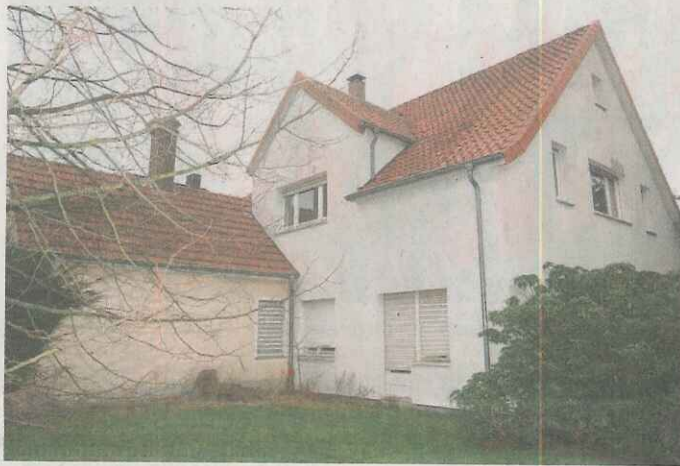
Abriss geplant: An der Amtsstraße soll die neue Kita gebaut werden. Dafür muss das Haus weichen. FOTOS (2): SYLVIA TETMEYER
